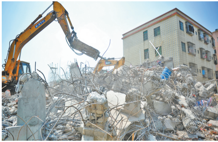
昨天上午,阜沙镇上南村一处6层违建楼房被拆除。
