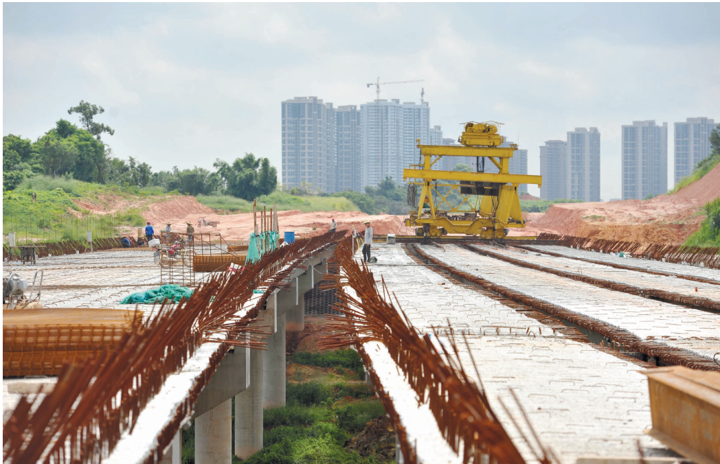
南外环延长线施工现场。
