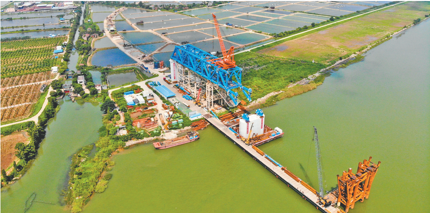
中山正在加快推进南沙港铁路建设,全力打造综合交通枢纽以提升城市承载力。图为8月8日,南沙港铁路跨洪奇沥水道特大桥主桥施工现场。
