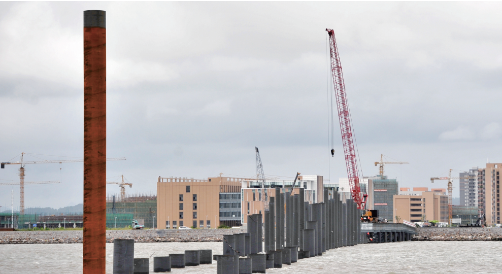
深中通道飞架珠江东西两岸,建成通车后,从深圳至中山原本2小时的车程将缩短为20分钟。图为6月25日,正在施工中的深中通道西登陆点的钢结构桥梁。
