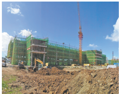
坦洲园建设正掀高潮。
