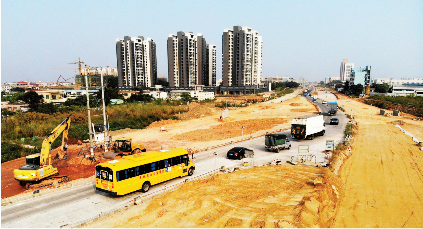
民众镇阳光大道正在施工,路面频繁有运输车辆经过扬起灰尘,该工地被责令整改。
