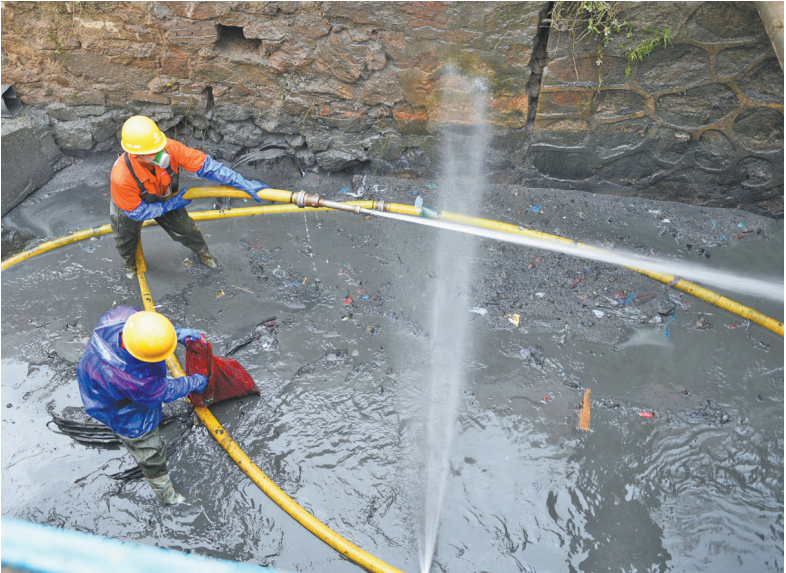
3月14日,南区情景路北侧河,工人正在清淤。
