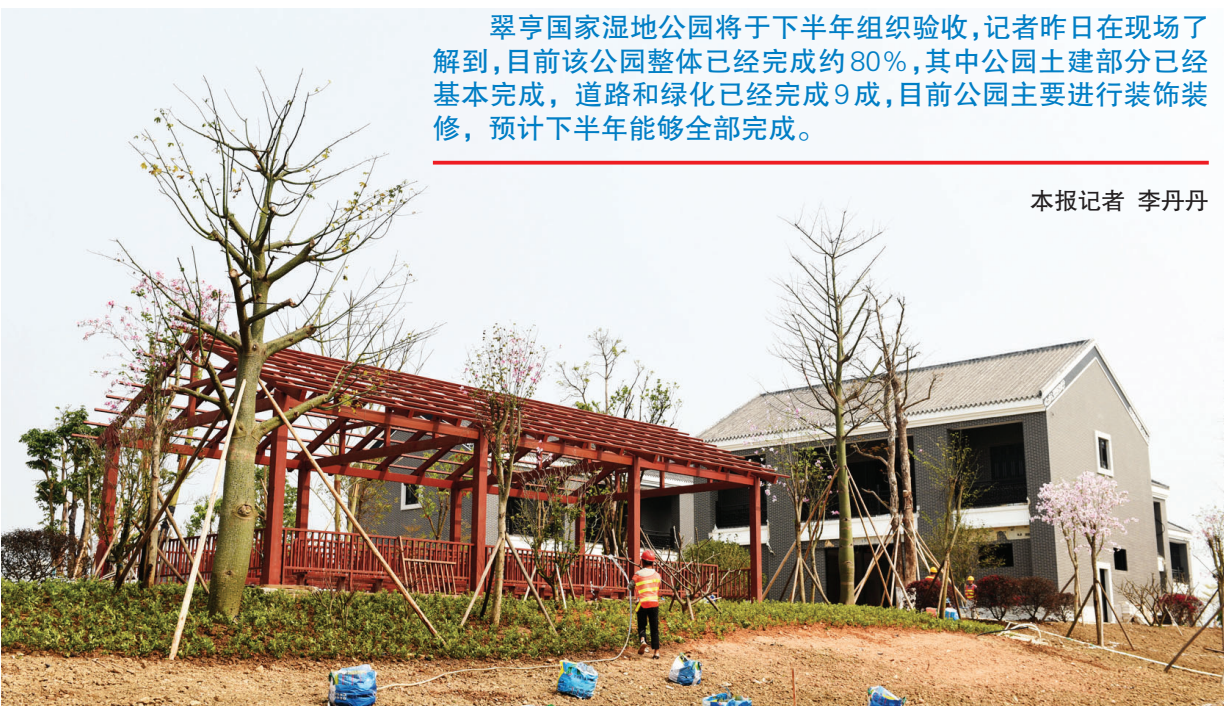
3月19日,翠亨国家湿地公园正在加紧绿化和建筑装修装饰,雏形显现。
