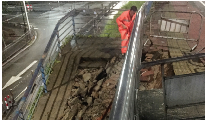
昨天下午两点半左右,东明桥往港口方向上桥处靠近步梯附近人行道发生垮塌事故,事故没有造成人员伤亡。据现场市政部门抢修人员介绍,事故原因是当天下午突降大雨,大量雨水从桥中央顺着人行道流下来,不停冲击此处路面下部泥土,最终导致外面的挡土墙垮塌。 目前这段人行道已经完全封闭进行抢修。 本报记者 王伟 摄
