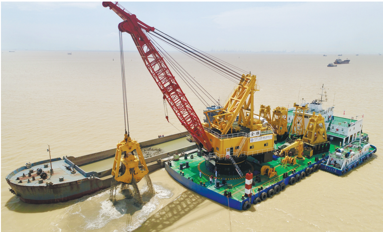
中交广航局“金雄”轮在现场精挖再现“海底绣花”绝技。
