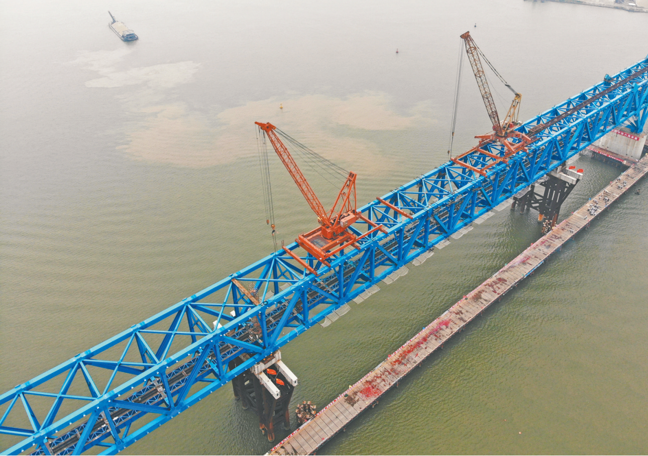
8月25日,南沙港铁路跨洪奇沥特大桥钢桁梁合龙。
