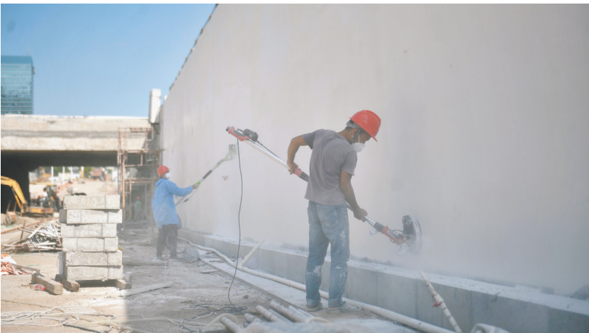
9月10日,工人在对博爱路-银通街立交下穿隧道进行内部装修施工。
