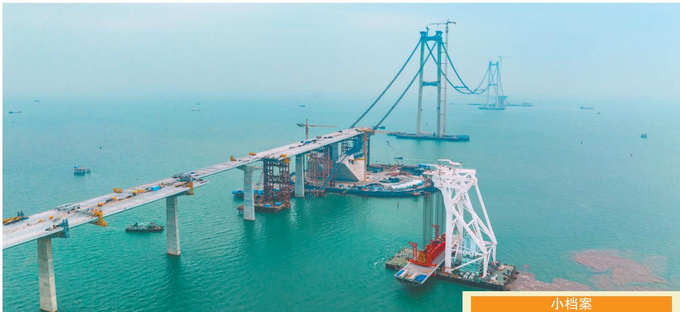
运架一体船正在架设深中通道非通航孔桥最后一根箱梁。
