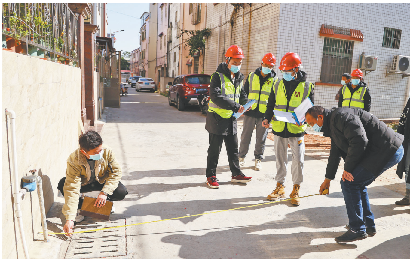
工作人员在西区街道现场测量，了解污水收集管道实际情况。
