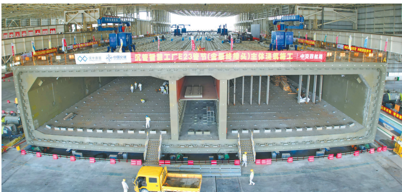
深中通道海底隧道沉管E23管节。
