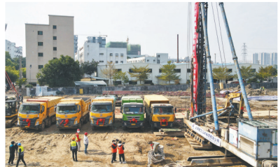
▲2022年12月29日,西区街道金昌工业聚集区改造升级一期项目正式启动建设。项目总投资额1.3亿元,预计2023年年底建成。
