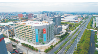
▲2023年1月20日,无人机航拍已建成的黄圃镇广林电器项目。2022年12月初,经市里认定,该镇广林电器等6个“工改”项目已竣工。
