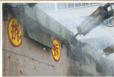
▲2022年11月15日,中山市2022年度第五批村镇低效工业园项目启动改造。这是小榄镇圩西一海威路工业园“工改”项目拆除现场。
