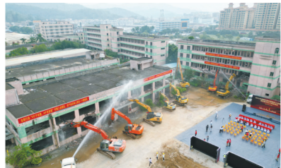
▲2022年11月15日,板芙镇举行第五批村镇低效工业园改造项目动工拆除现场。
