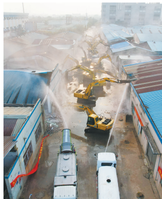
▲2022年1月4日,中山高规格召开工作动员会,吹响村镇低效工业园升级改造号角。这是小榄九洲基广成路工业园改造拆除低效工业厂房现场。
