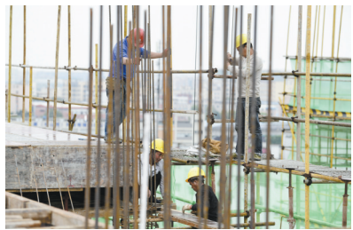
▲2022年4月2日,中山市金莱制衣有限公司在建项目,施工人员在层面上钉模板。
