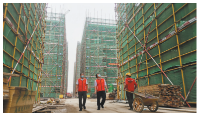
▲2022年12月17日,古镇镇海洲村嘉隆科技园,古镇镇“工改办”成员现场调研高标准厂房建设进度。当日,科技园一期大部分厂房已经封顶。
