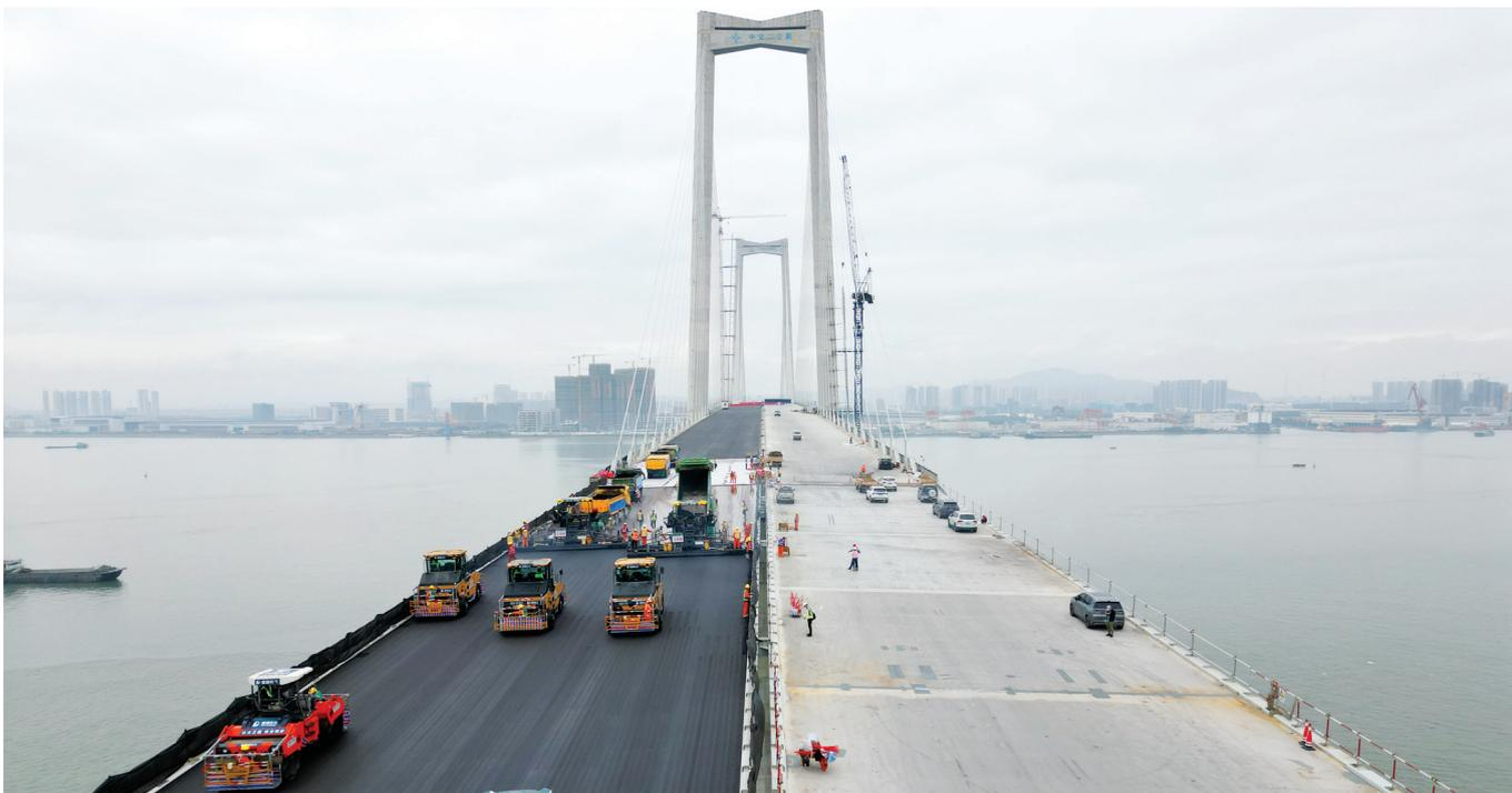
深中通道中山大桥主桥左幅钢桥面正在实施铺装施工。
