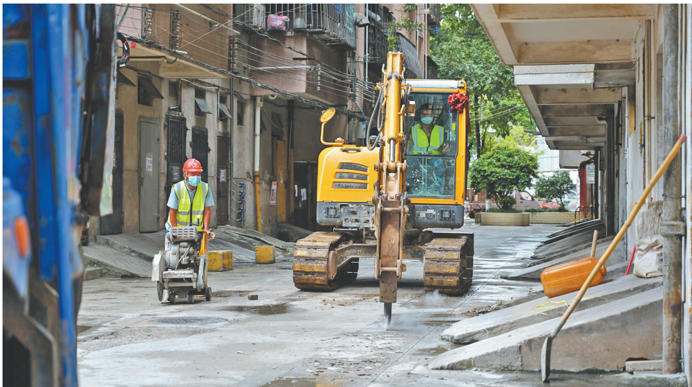
莲峰新村老旧小区污水管网建设项目。
