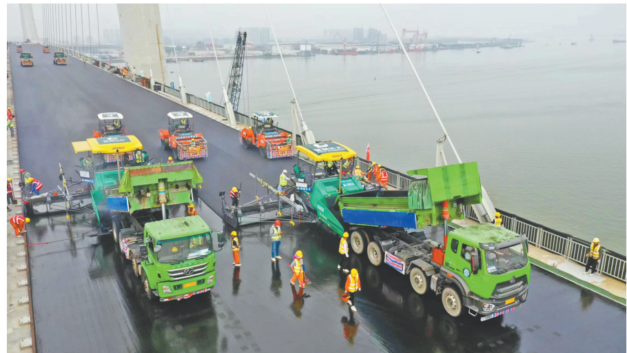
深中通道中山大桥桥面铺装现场。
