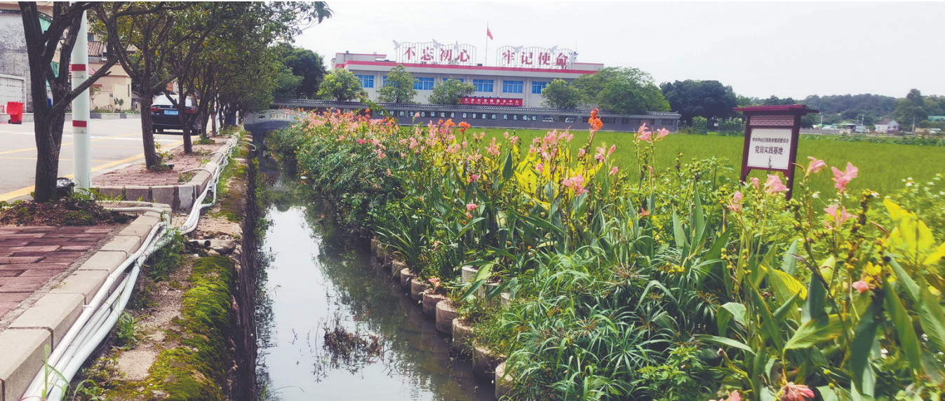
左步村农村生活污水治理项目竣工验收。
