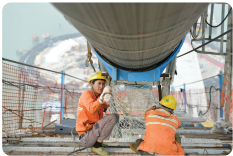
吊装开始前,施工人员对缆载吊机进行抱箍紧固。
