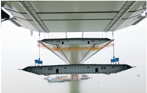
一片钢箱梁在提升过程中。
