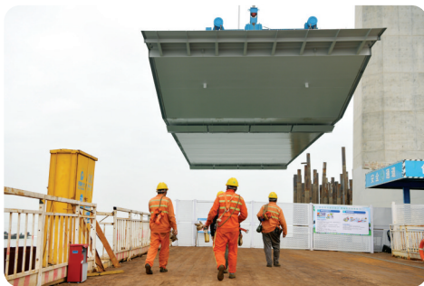
缆载吊机吊具与钢箱梁临时吊点连接完成,钢箱梁开始提升。
