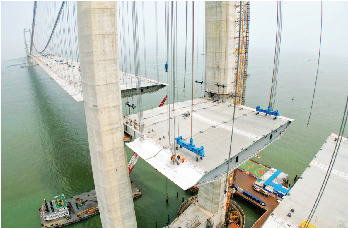
钢箱梁被平稳拉升到设计标高,施工人员将吊索与梁段永久吊点通过销接进行连接。
