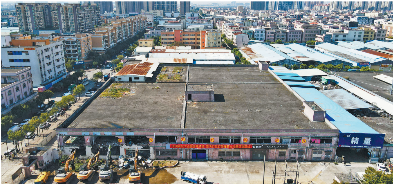
1月30日,中山市2023年度第一批村镇低效工业园改造项目集中拆除暨第一季度制造业项目集中动工仪式(小榄分会场)现场。(资料图片)
