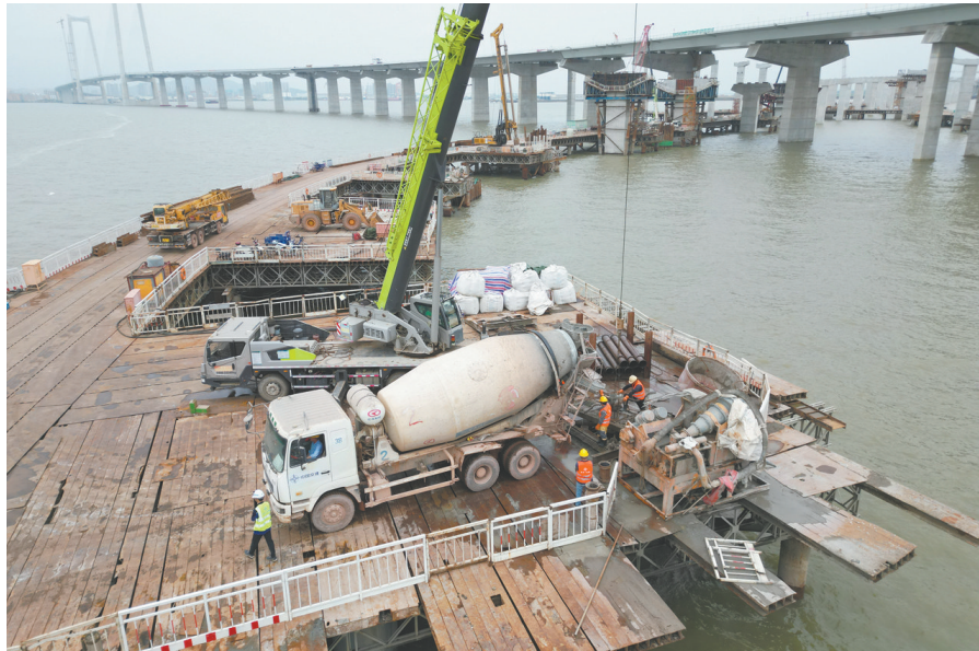
5月10日，深中通道万顷沙互通最后一根桩基浇筑完成。
