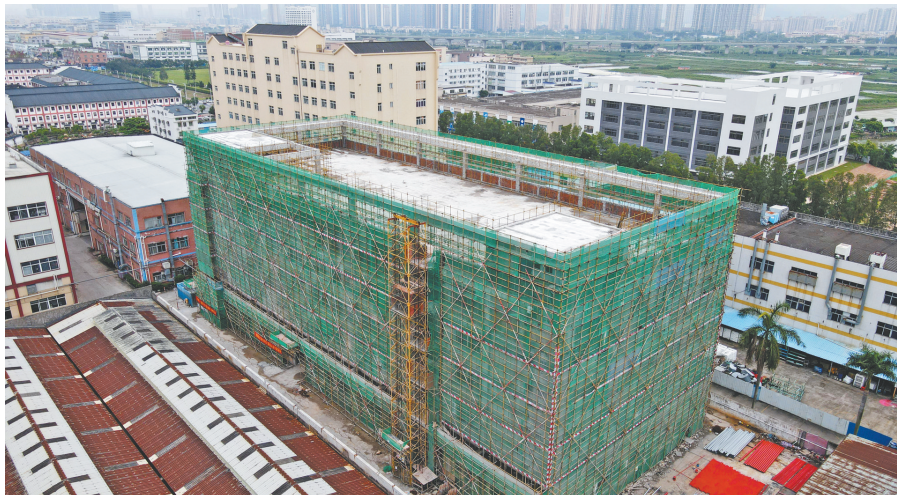
中山骏腾塑胶制品有限公司二期工地,五层厂房已封顶。
