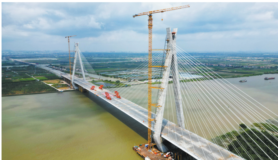
5月21日,南中高速洪奇门特大桥顺利合龙。
