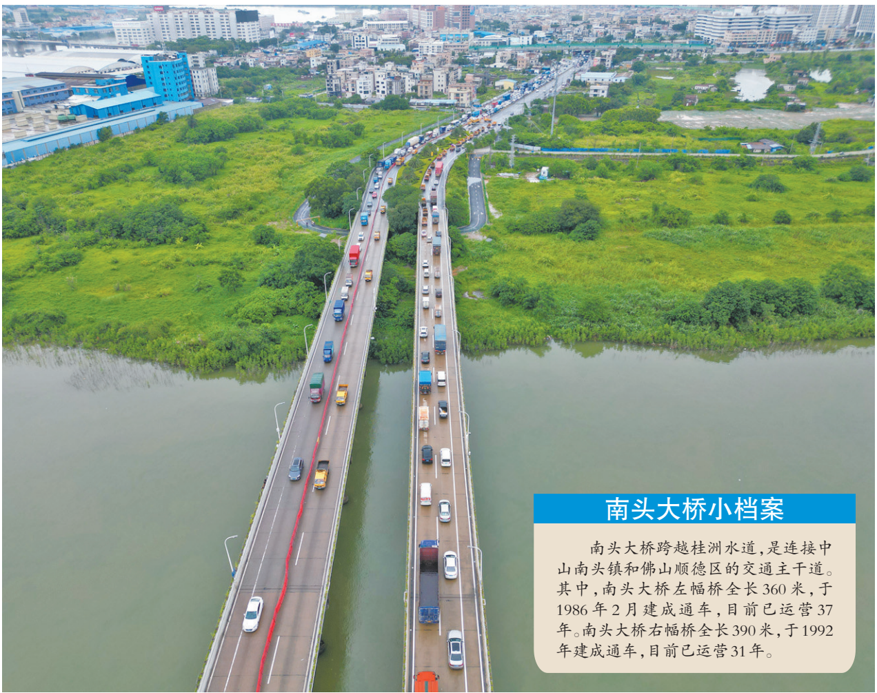
6月8日下午,南头大桥修复工程竣工试通车,大桥恢复左右幅双向四车道通行。 本报记者 缪晓剑 摄
