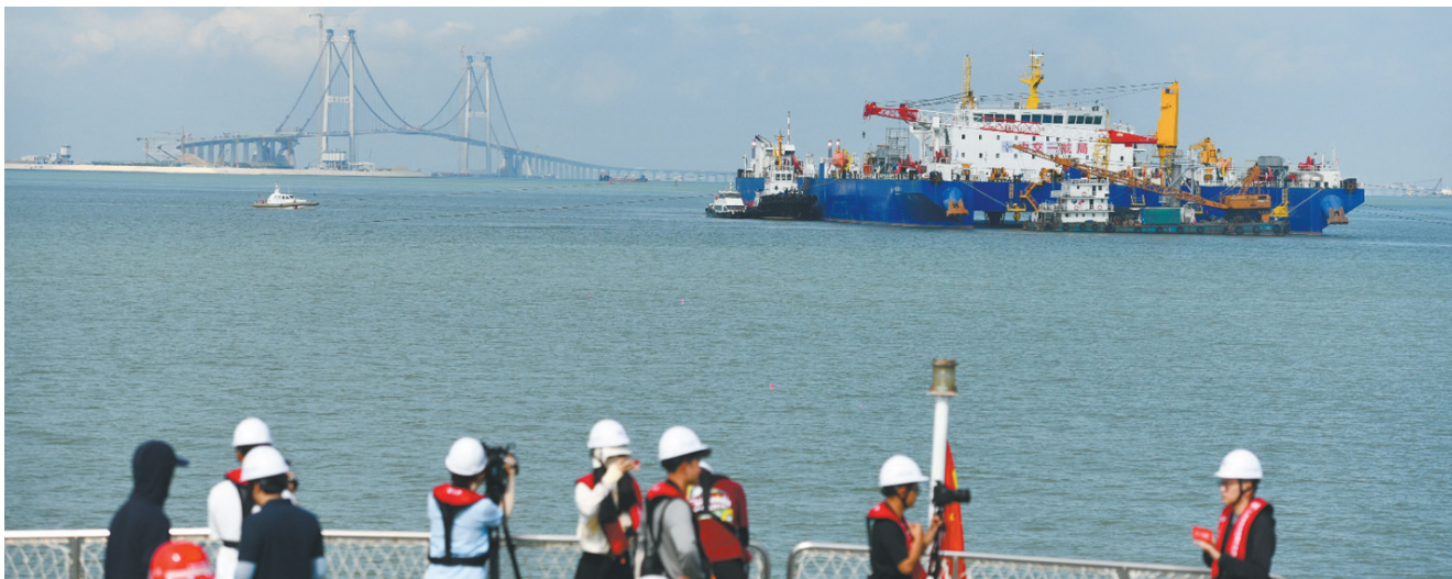
6月11日，中交一航局浮运安装一体船“一航津安1”在作业水域施工。
