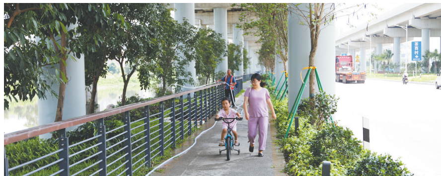
翠亨快线提升改造主体工程完工，道路景观绿化和隧道亮化显著提升。本报记者 王云 摄
