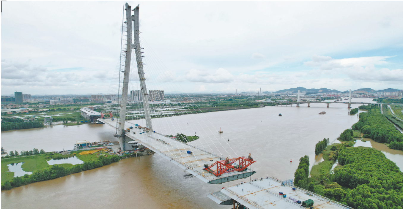
6月28日,南中高速横门西特大桥中山侧合龙施工现场。
