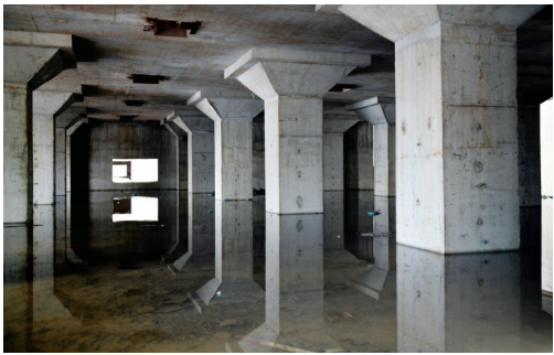
大直径筒仓底层结构。
