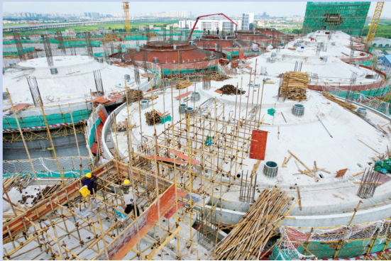
工人在大直径筒仓顶部施工。
