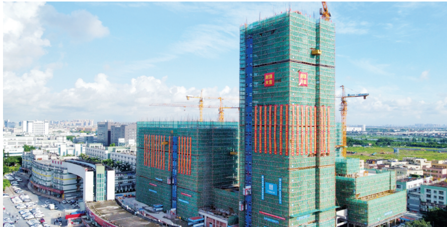
▲火炬开发区电子基地科创园项目(资料图片)。
