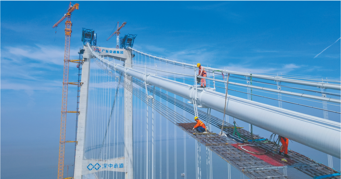
伶仃洋大桥上,建设者在进行猫道面网拆除施工。
