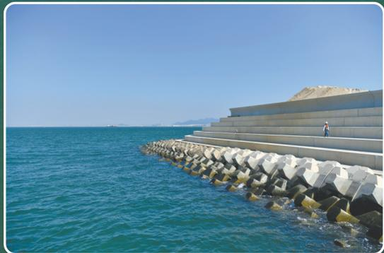
深中通道西人工岛的防波堤和挡浪墙。
