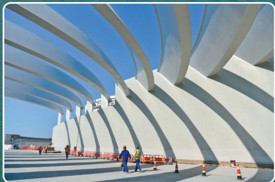
西人工岛隧道入口处的遮光罩如鱼骨一般,可以让司乘人员适应隧道内外的光线变化。
