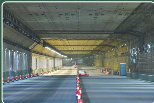
全长6845米的深中通道海底隧道,是世界上最长、最宽的海底钢壳混凝土沉管隧道,目前沉管隧道内部正在进行“精装修”。
