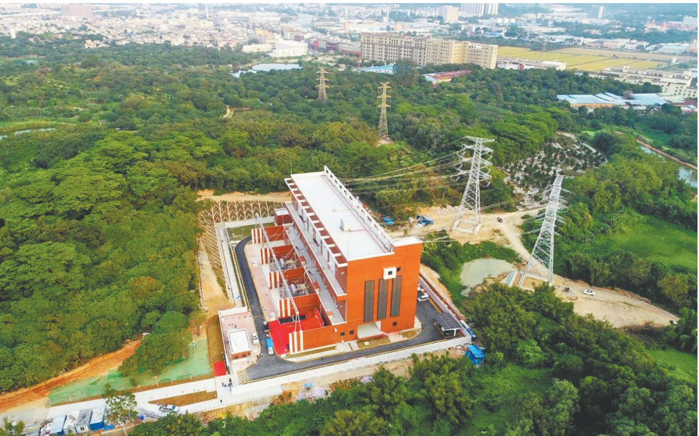
中山220千伏沙溪输变电工程顺利投产。 通讯员 孙嘉彪 摄
