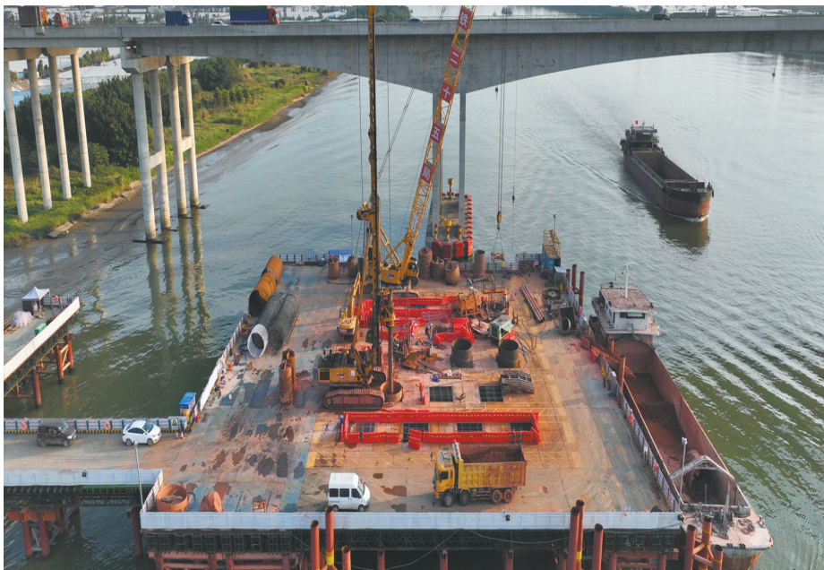
深江铁路12标控制性工程跨虎跳门水道特大桥主塔首根桩基于近日完成浇筑。 通讯员 吴明耀 摄
