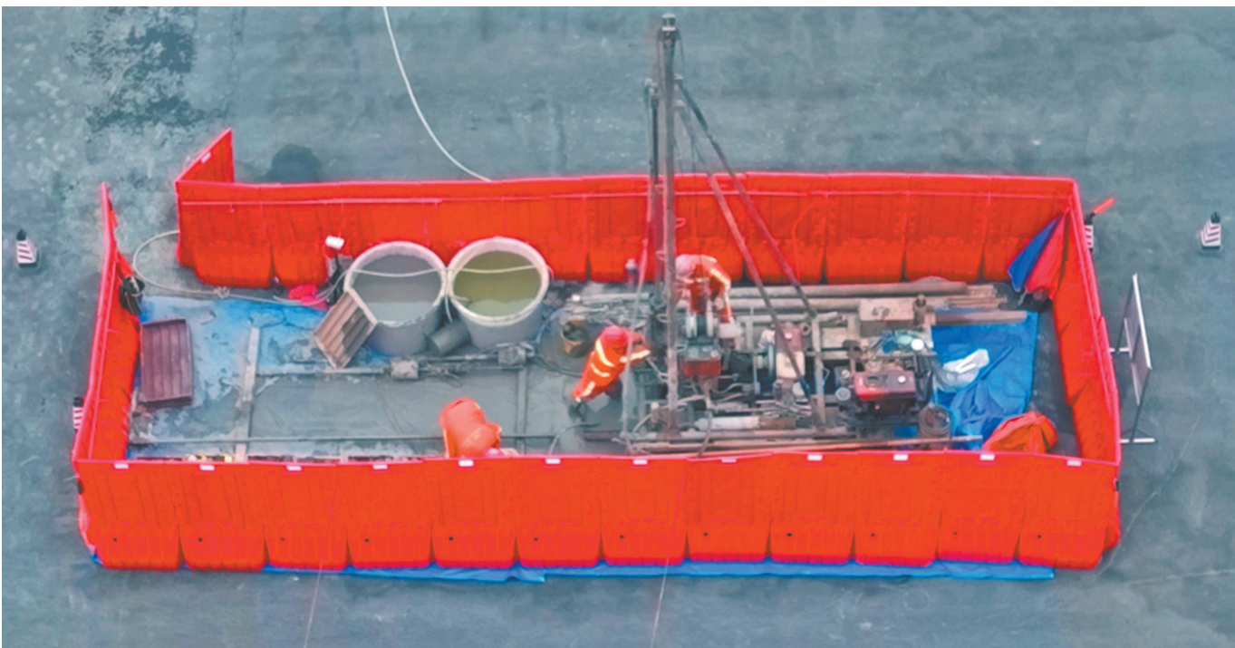
2月27日,中珠城际翠亨新区马鞍岛段实施前期深化研究勘察作业现场。
