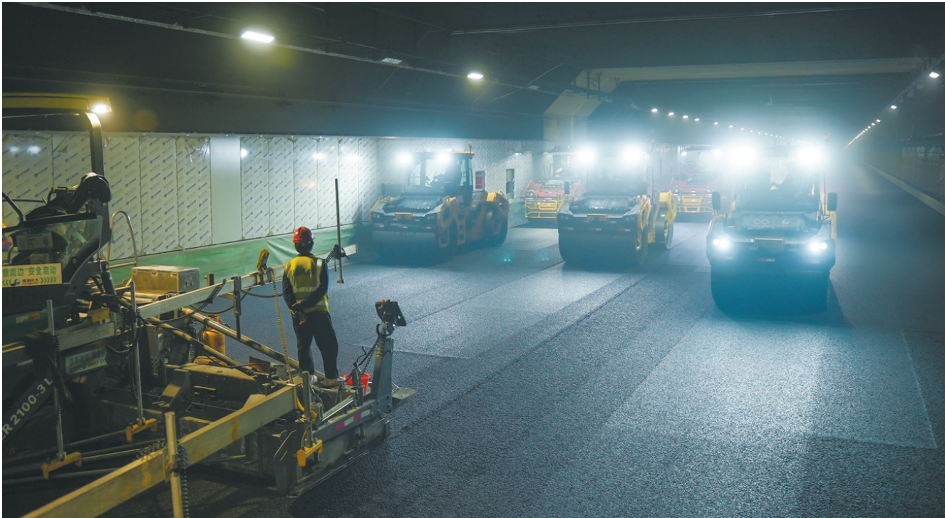
深中通道进行隧道沥青路面施工。
