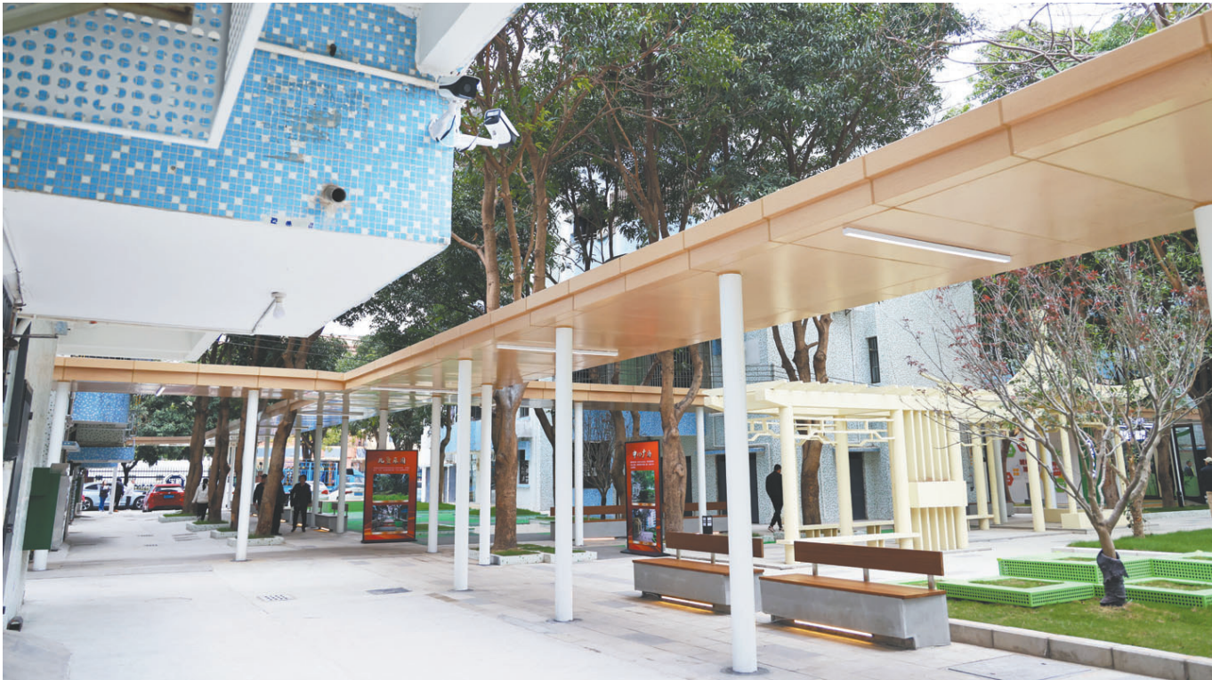
东区街道松苑横街小区风雨连廊。(资料图片)
