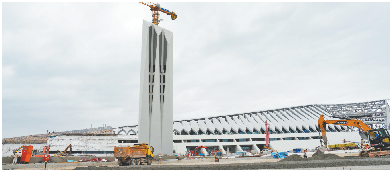
位于伶仃洋深处的深中通道西人工岛,迎海而立的主楼雏形初现,高耸的风塔外架已拆除完毕。
