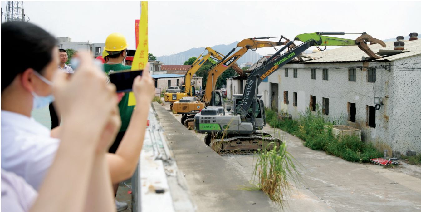
2022年7月28日,南区街道举行园山仔白石环“工改”项目拆除启动仪式。(资料图片)
