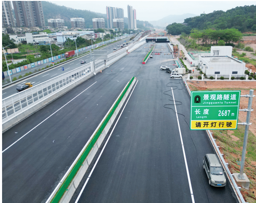
中开高速景观路隧道长约2897米,是“中山陆域最长最宽隧道”。
