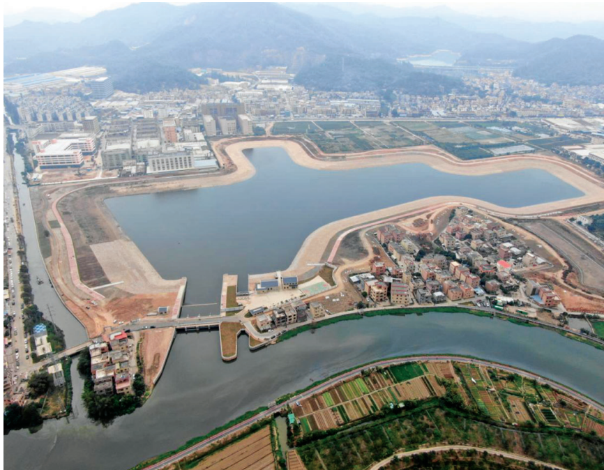
三乡中心蓄洪湖及泵闸配套工程纳入全域土地综合整治试点工程后,周边实现内涝治理、耕地质量双提升。
