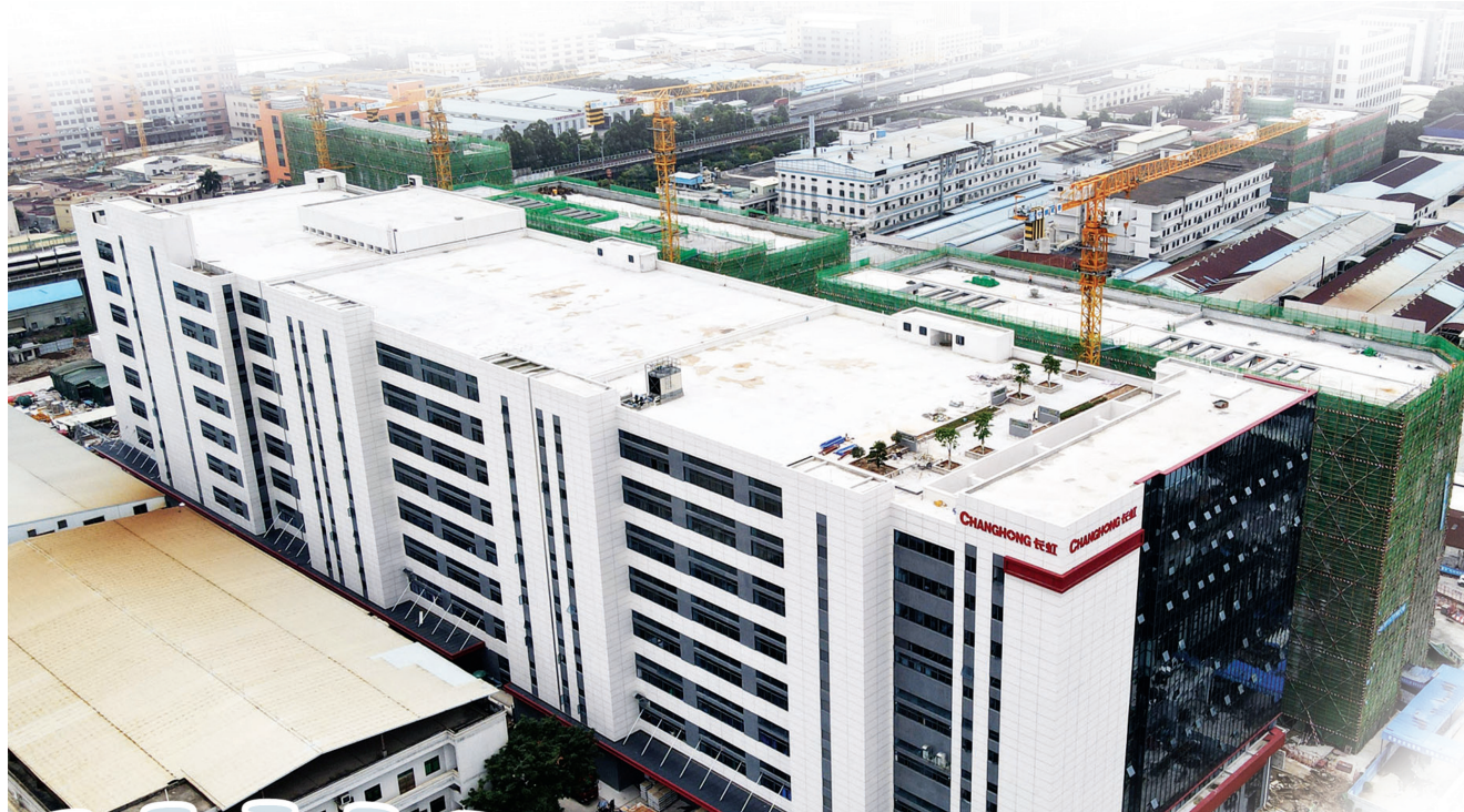
南头镇智能家电制造业创新中心项目，一期即将完工，二期主体已封顶。
