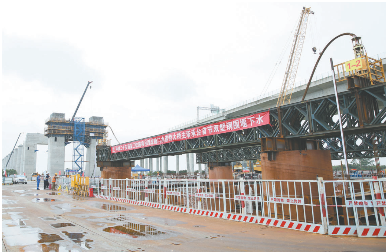
跨虎跳门水道主桥首节围堰下水施工现场。
