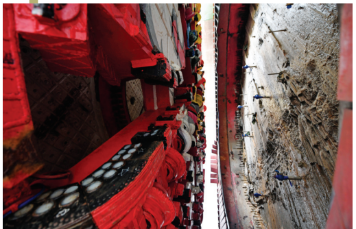
▲盾构始发前,盾构机刀盘与洞门距离1.2米。
