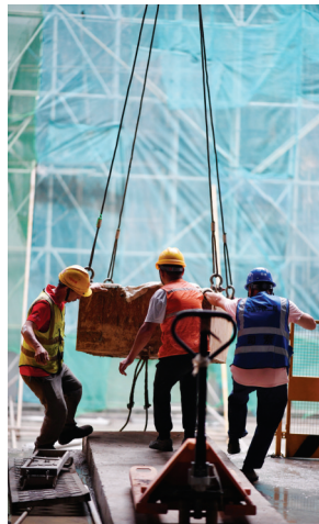
▲5月22日,工人正在井口吊装施工物料。
