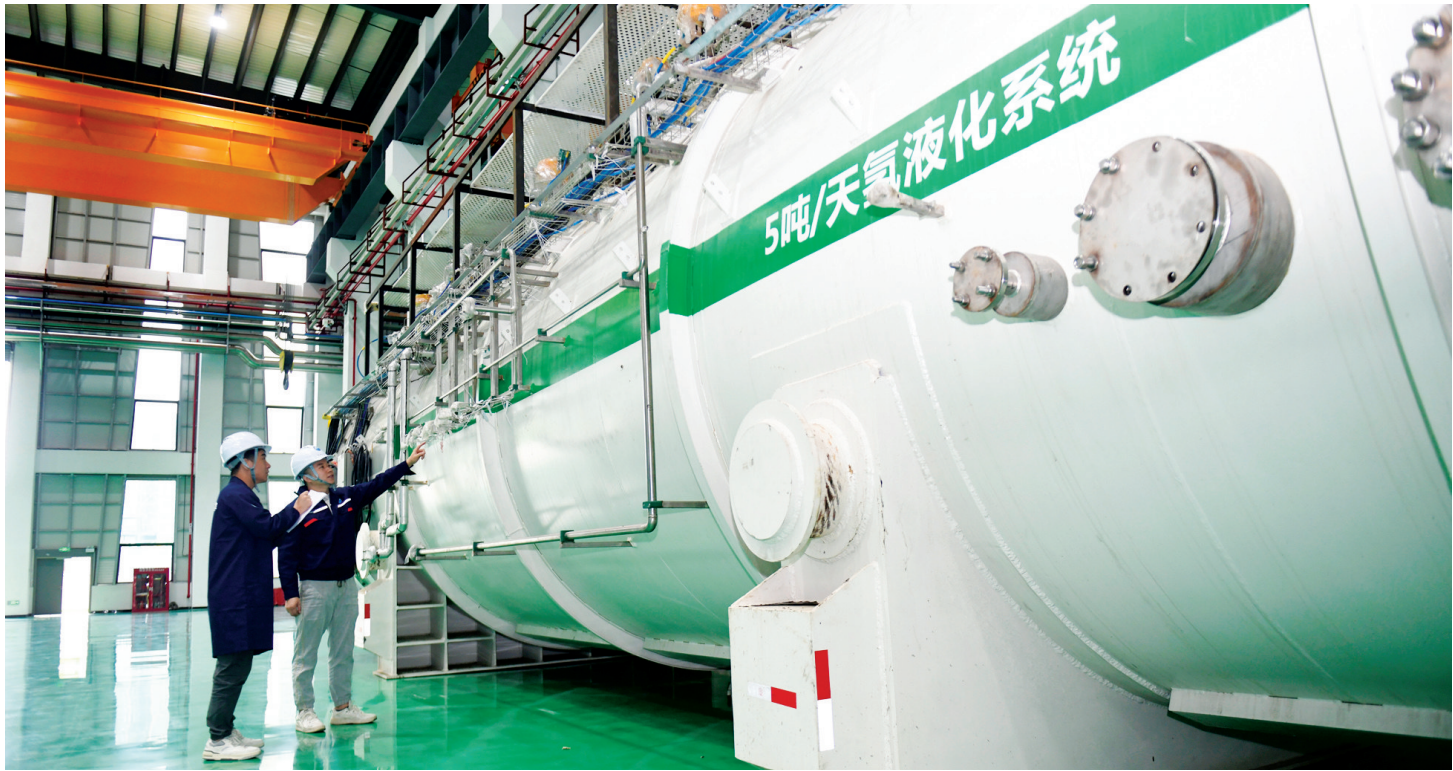
6月6日，技术人员正在检查罐体外部各种管线的运行情况。
