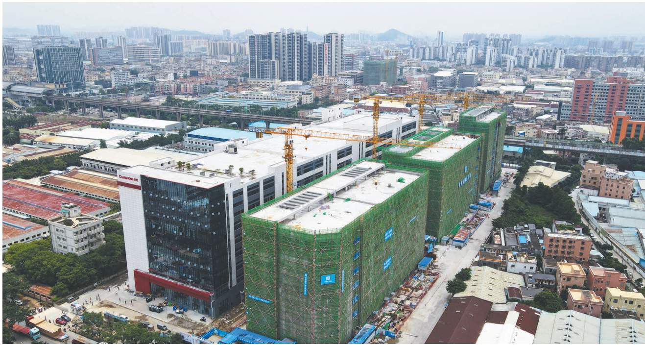
建设中的南头镇智能家电制造业创新中心项目。(资料图片)
