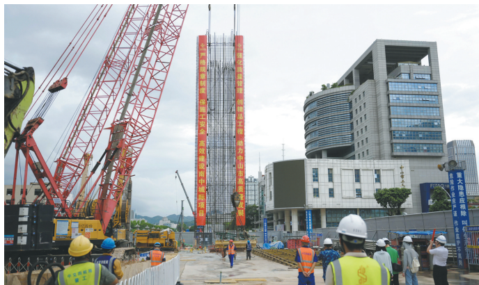
7月31日,南中城际兴中站地连墙顺利封闭。地连墙完成施工后,下一步将开展兴中站基坑开挖施工。本报记者 缪晓剑 摄
