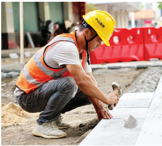
8月7日,华柏路施工现场,许庆春正在铺路面地砖。
