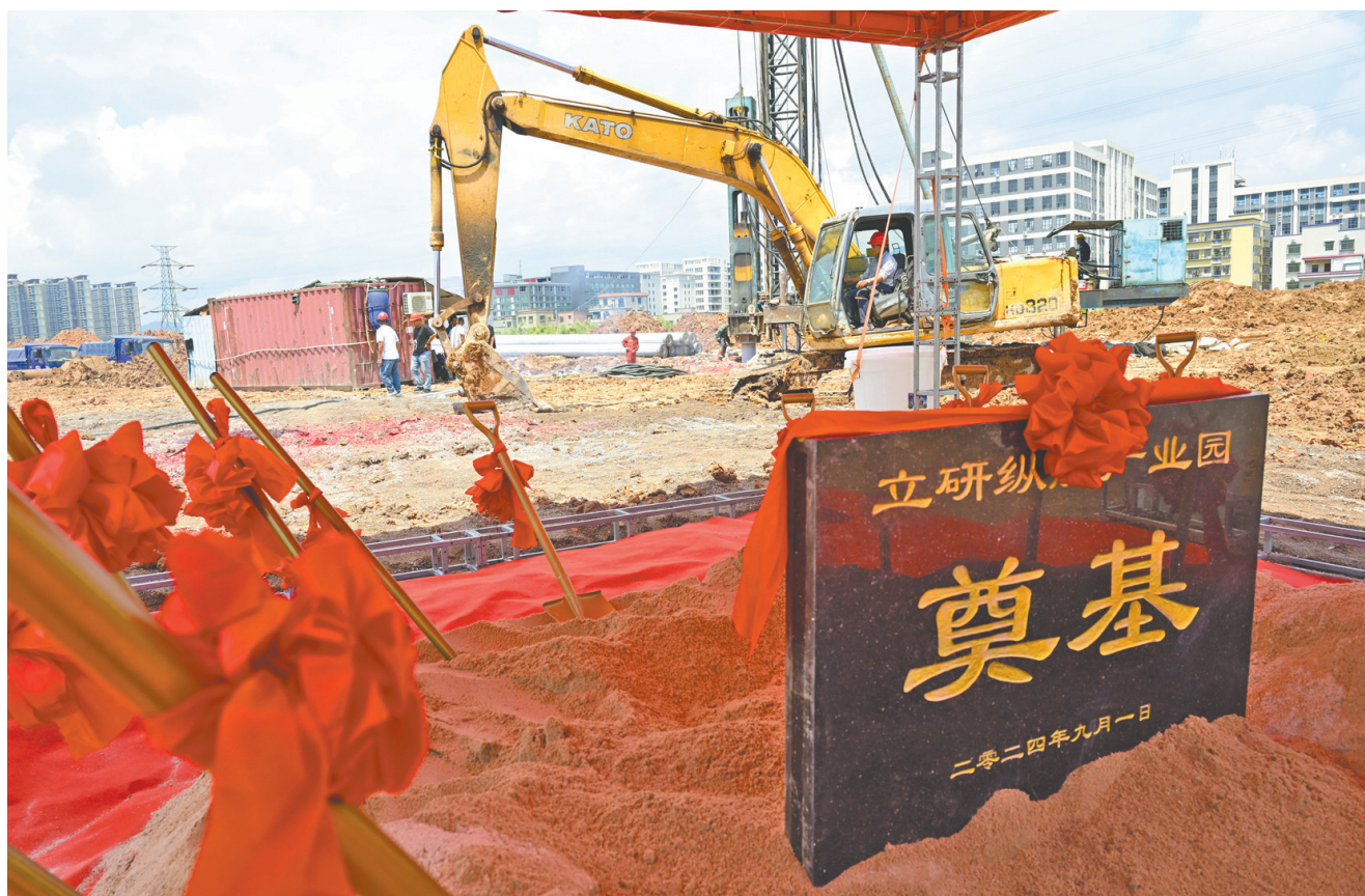
立研纵航产业园奠基现场。
