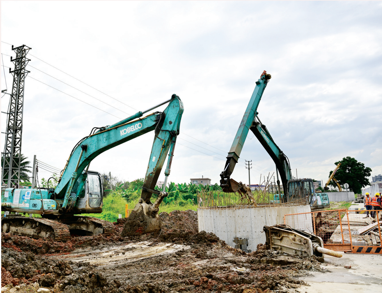
9月18日,金三大道旁的民三联围项目,挖土机正将井下的淤泥沙石清走。
