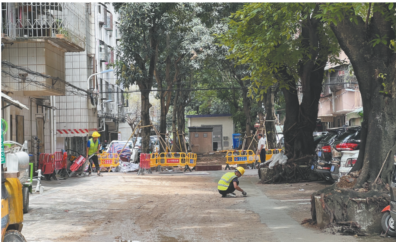
仙湖新村旧改项目进行中。
